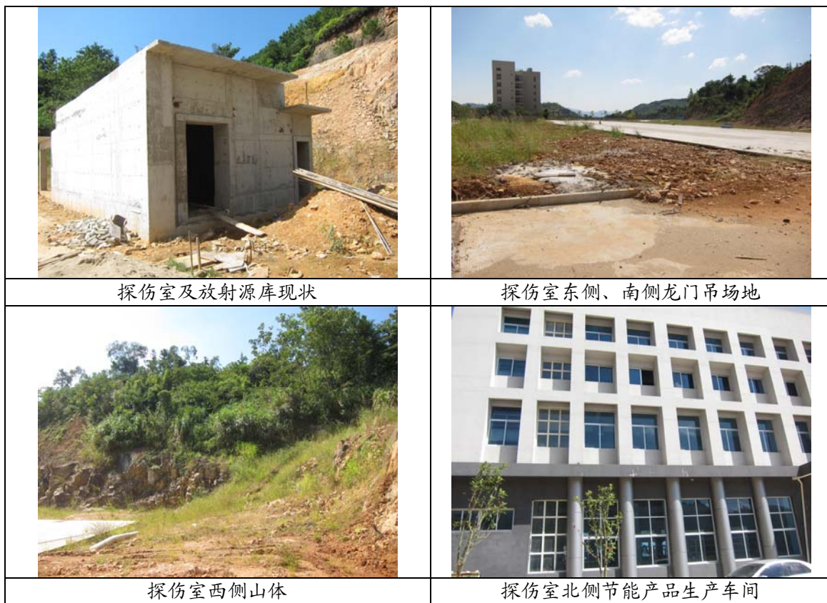
图 5-2 X 射线探伤室及放射源暂存库环境现状图
